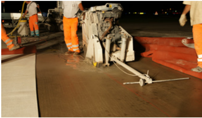
Sciage des joints d'une dalle fraîchement mise en œuvre
