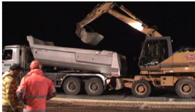
Déchargement du béton sur le chantier
