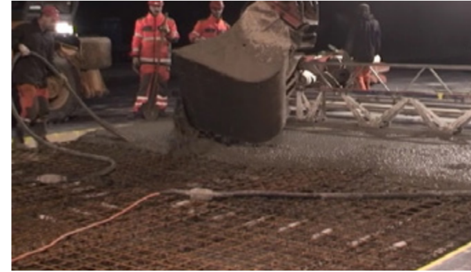
Vibration de surface (par exemple règle à araser)
