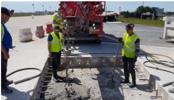
Production du béton (camion malaxeur mobile)
