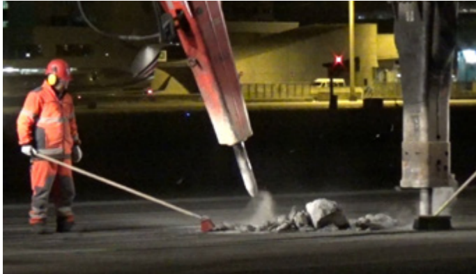
Forage et mise en place des goujons
