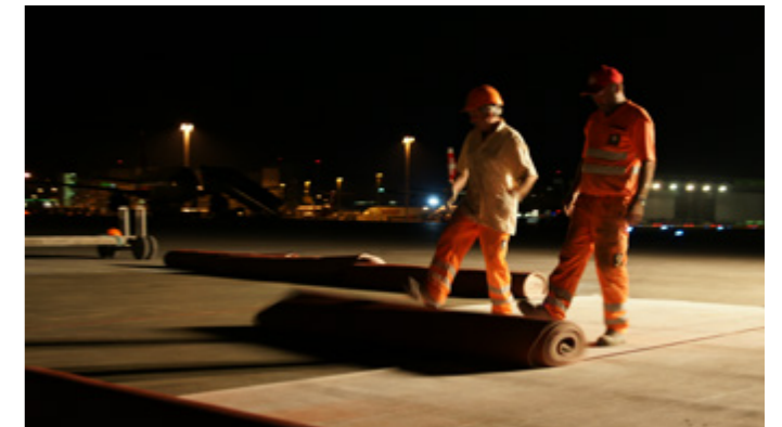
Mise en place des bâches isolantes
