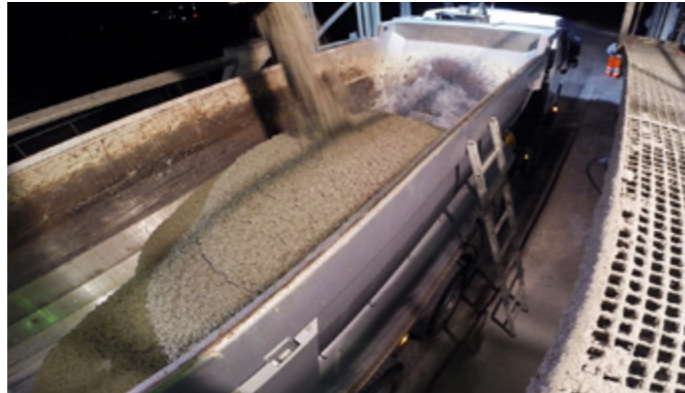
Déchargement du béton sur le chantier
